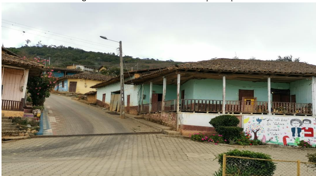
Imagen 28. Red eléctrica en la parroquia.
