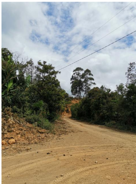
Imagen 25. Cableado eléctrico fuera de la cabecera parroquial.
