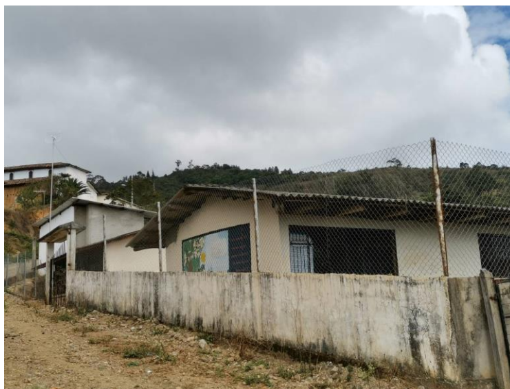
Imagen 1. Colegio de Bachillerato Frontera Sur.
